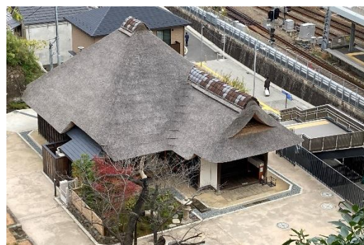
権現山公園 旧円通寺客殿(木村家住宅主屋)
