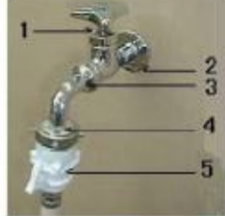
図1 作業前の蛇口
