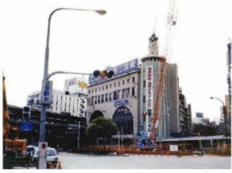
震災被害を受けた旧神戸阪急ビル東館
