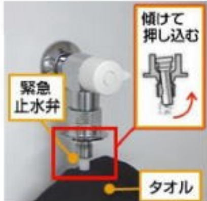
図2 緊急止水弁の先端をタオルなどで押さえ、止水弁を傾けて押し込み、中にたまっている水を抜きます。
